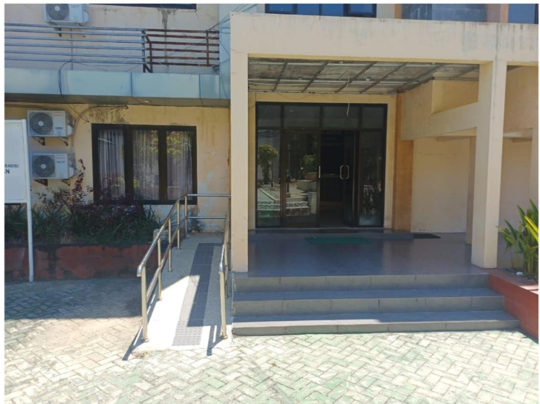
GEDUNG ASRAMA A
